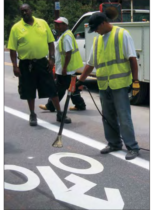
Las cuadrillas de trabajo de Winston-Salem DOT instalando la marcación, por sistema de calor, del primer carril para bicicletas sobre Reynolda Road.
